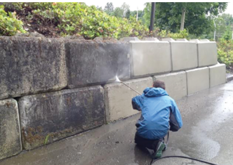
Curățirea pereților cu aburi sub presiune, sursa: www.rynolawncare.com , ianuarie 2018
